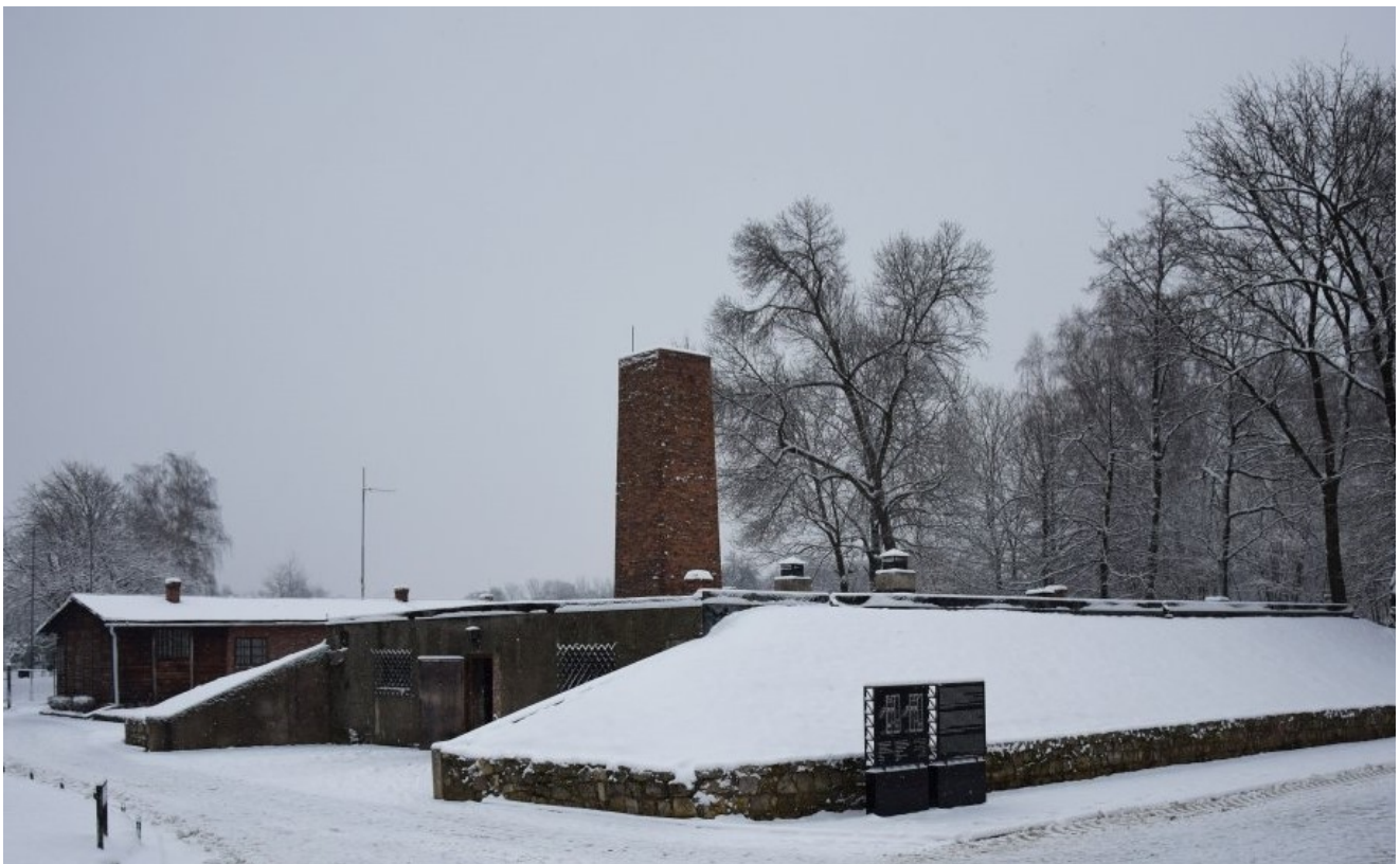
Budynek byłego krematorium na terenie KL Auschwitz I (fot. M. Foks)
