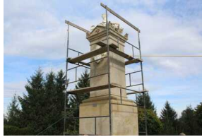
Pomnik upamiętniający gen. Jana Henryka Dąbrowskiego - prace remontowe
