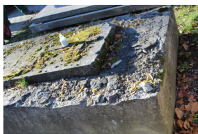
Adolfa Pomaskiego - przed remontem
