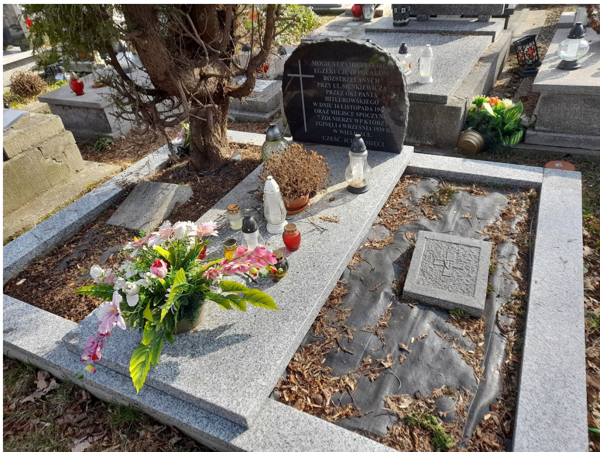
Grób przed remontem. Fot. IPN
