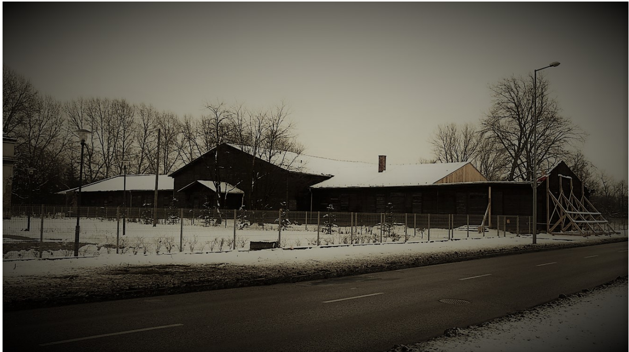
Budynek byłej kuchni SS, styczeń 2015 r. Fot. Maciej Foks
