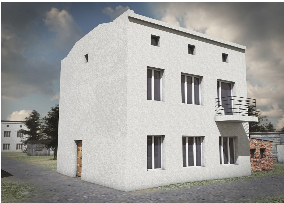
Zrekonstruowany budynek komendantury obozowej przy ul. Przemysłowej 34 w Łodzi (punkt „31”), za nim widoczny budynek kwatermistrzowski (punkt „28”) oraz drewniana budka trębacza (punkt „29”) (Mapa multimedialna niemieckiego obozu pracy dla polskich dzieci przy ul. Przemysłowej w Łodzi/IPN Oddział w Łodzi).
