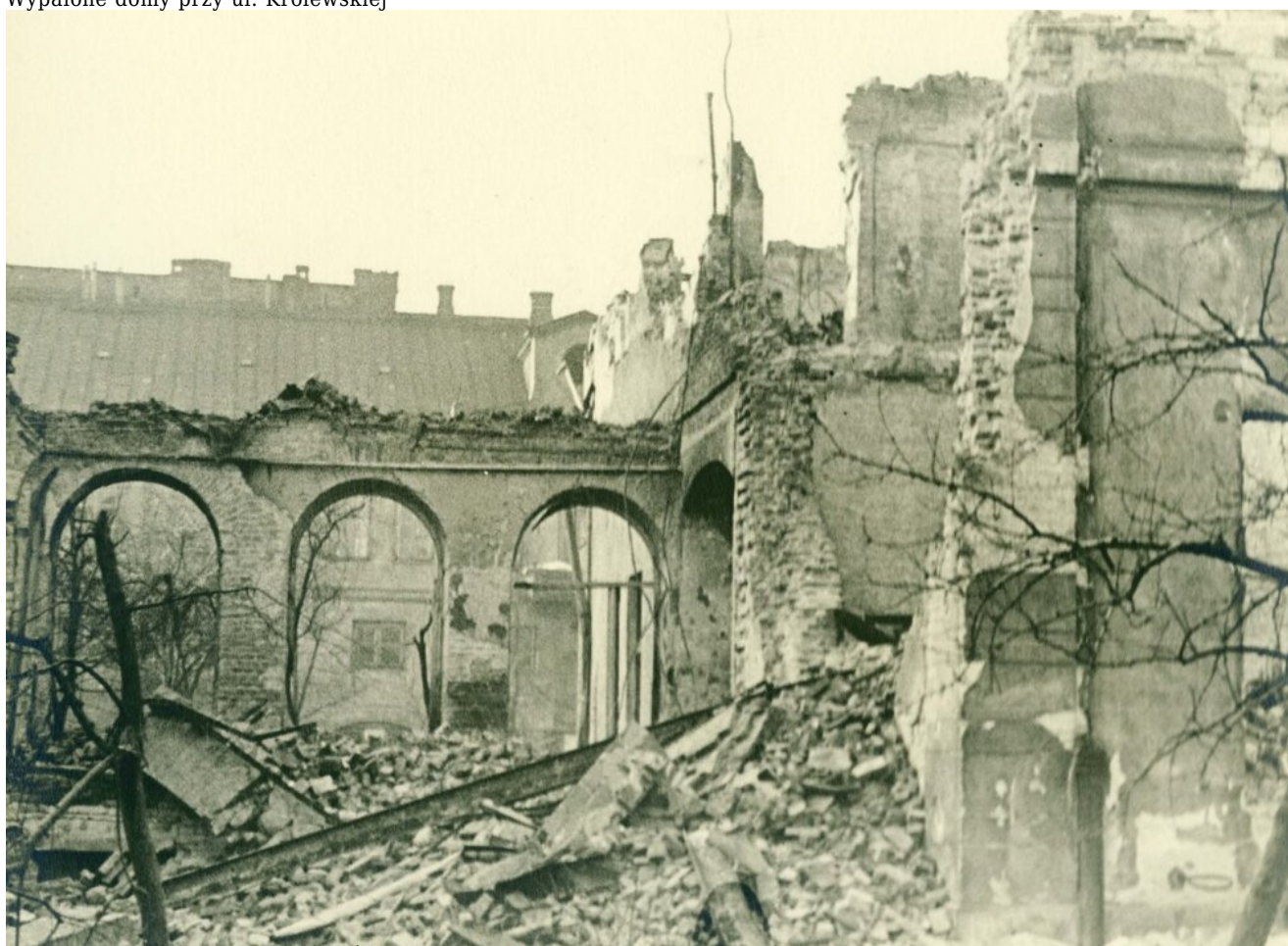
Spalone tylne pawilony Szpitala Św. Ducha przy ul. Elektoralnej 12
