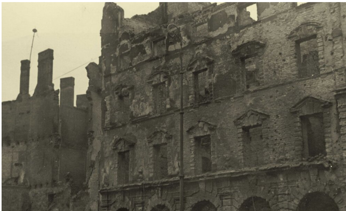
Wypalone domy przy ul. Królewskiej
