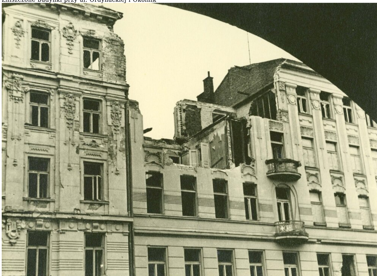
Uszkodzone kamienice przy alei 3 Maja
