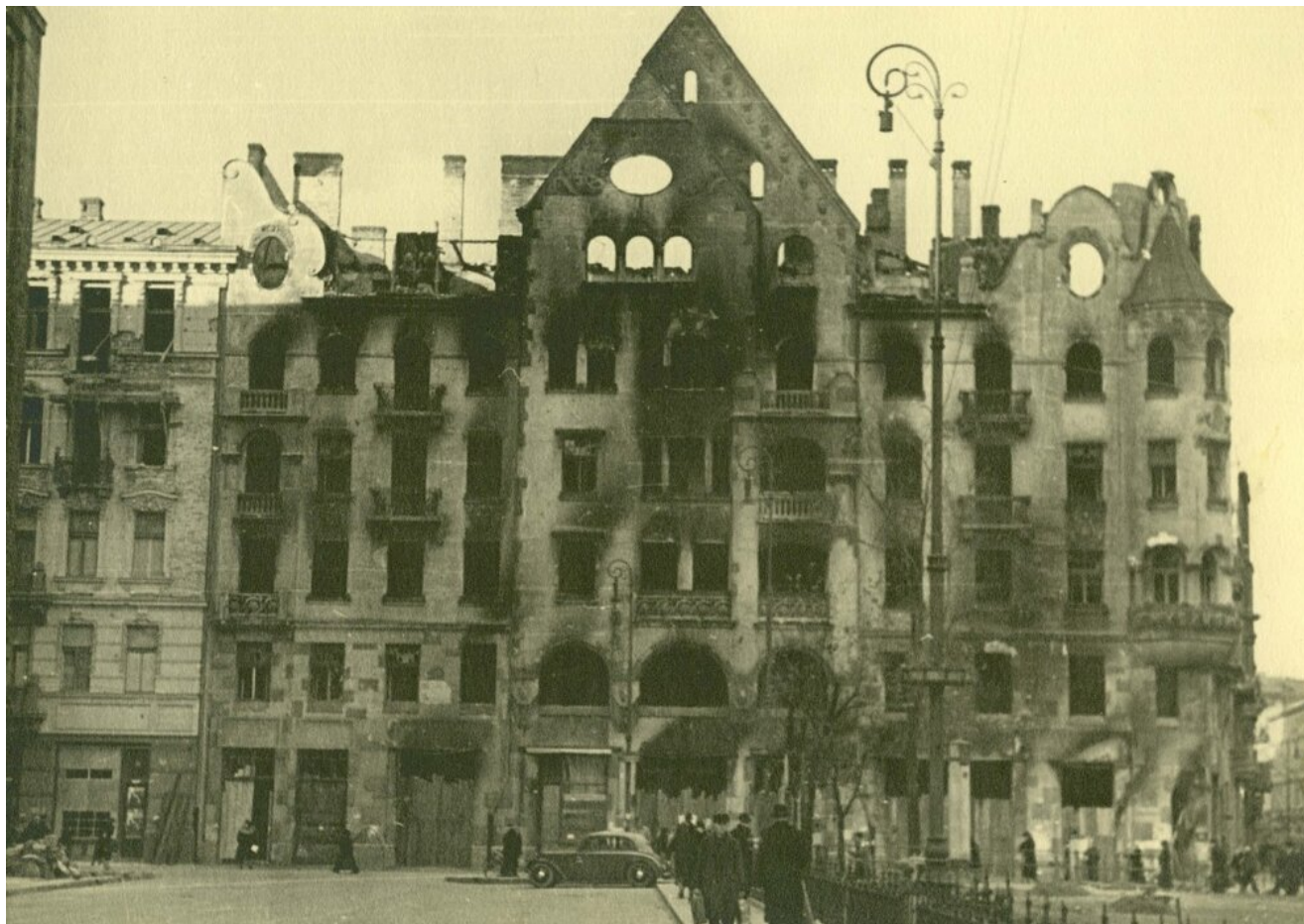
Spalona kamienica hr. Ostrowskiego na rogu ul. Świętokrzyskiej i Mazowieckiej - widok z pl. Napoleona (obecnie pl. Powstańców Warszawy)
