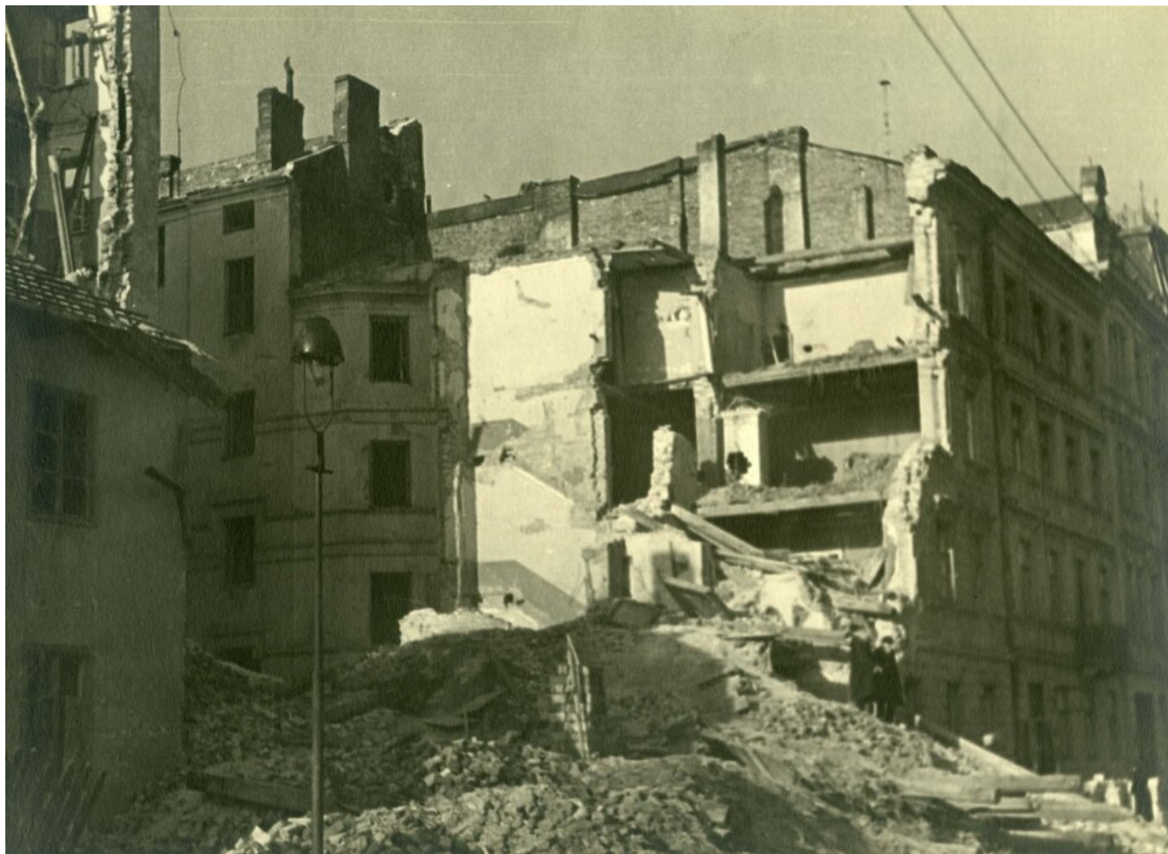
Częściowo zburzony budynek przy ul. Emilii Plater
