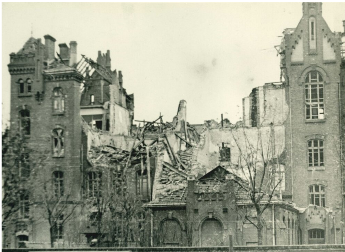
Zniszczony budynek Szkoły Powszechnej przy ul. Szerokiej (obecnie ul. ks. Ignacego Kłopotowskiego)
