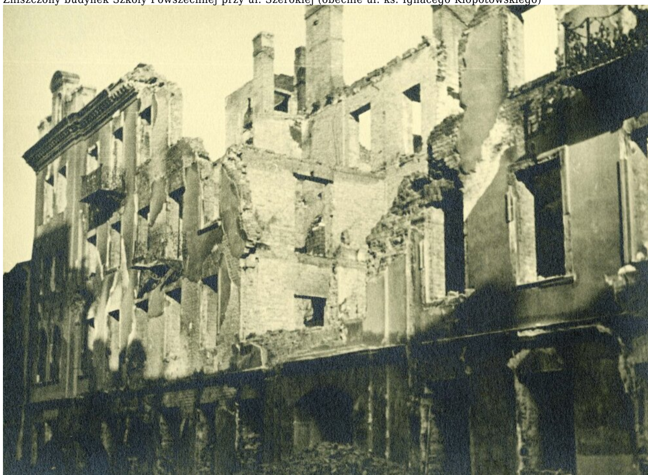
Zniszczone domy przy ul. Zamoyskiego
