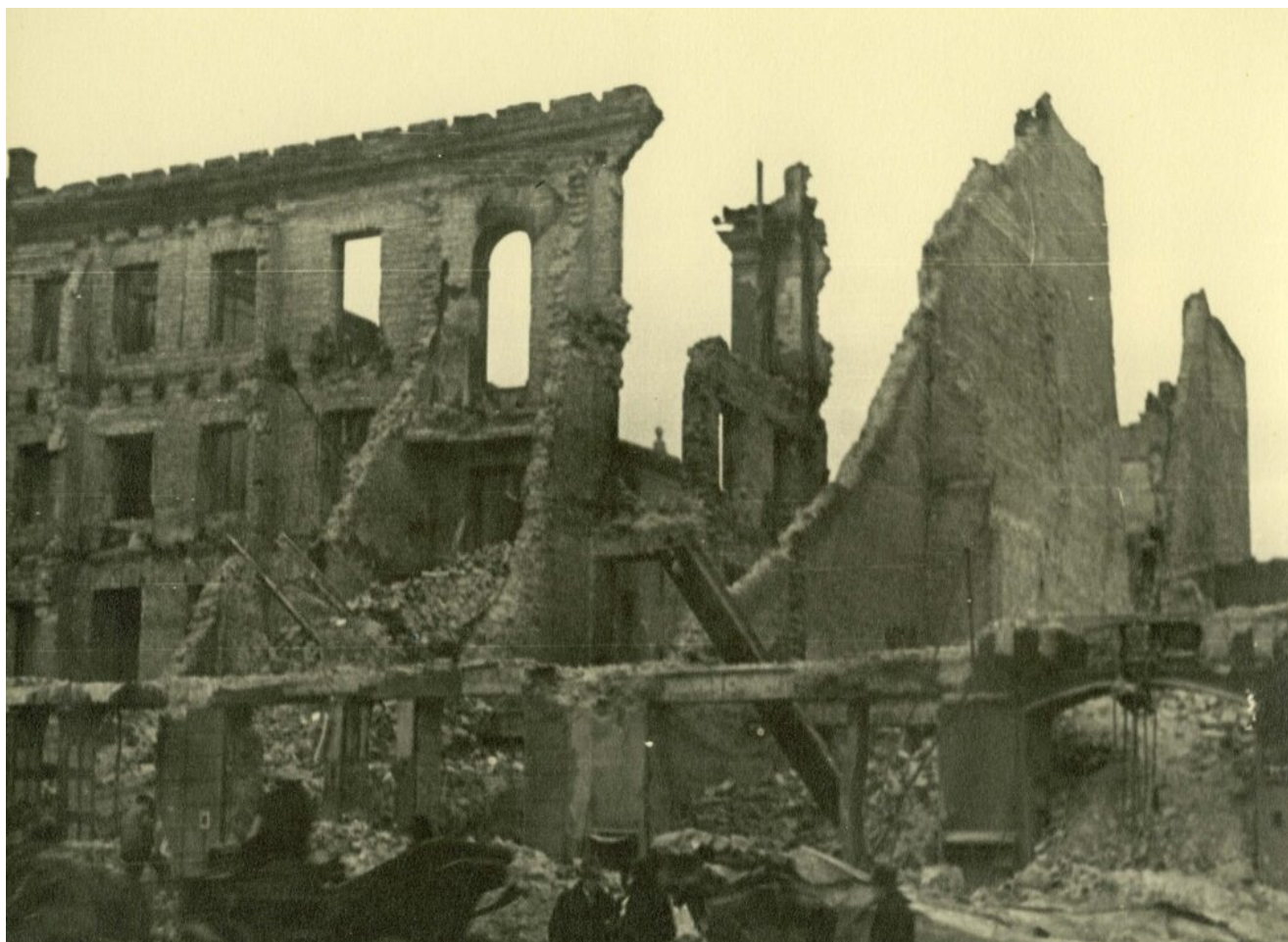
Zniszczona kamienica przy ul. Rynkowej (współcześnie rejon Parku Mirowskiego)
