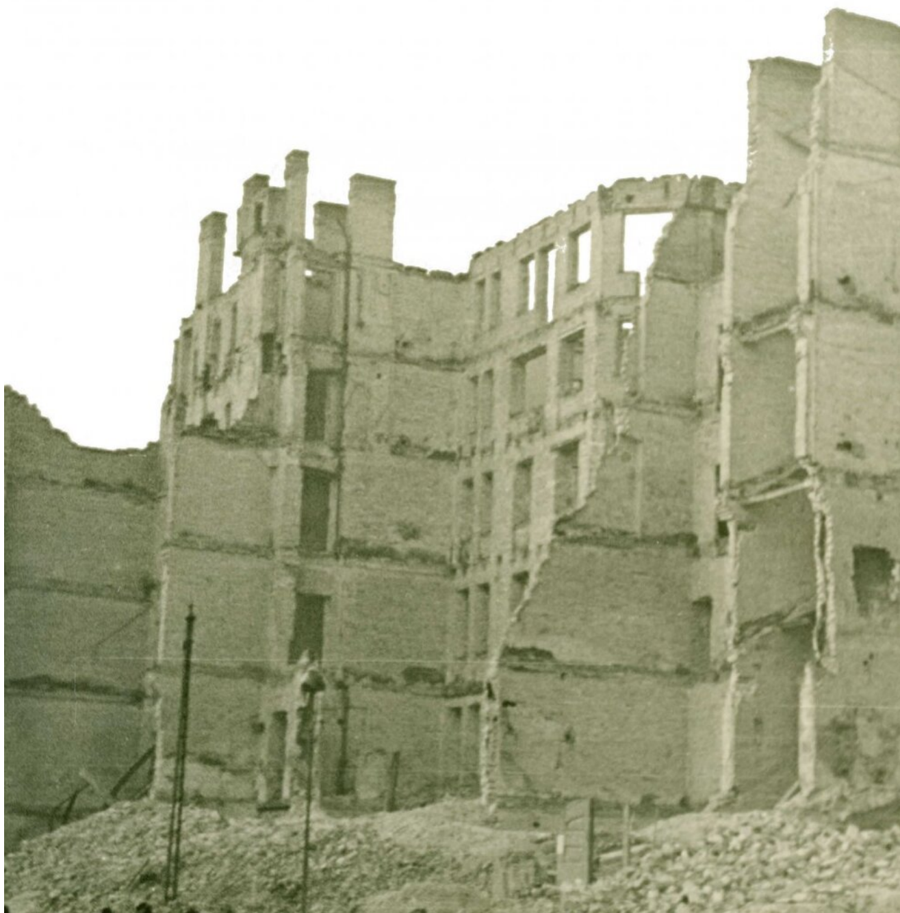
Ruiny zniszczonych kamienic przy ul. Franciszkańskiej (prawdopodobnie po północnej stronie między ul. Nalewki i ul. Bonifraterską)
