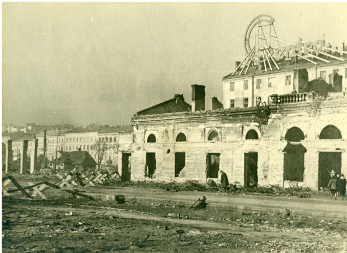
Okolice Dworca Głównego. Na pierwszym planie zniszczony budynek tzw. „Nowej Poczkalni” dawnego Dworca Wiedeńskiego, za nim tylna fasada Hotelu „Astoria”. W tle po lewej zabudowa wzdłuż ul. Chmielnej
