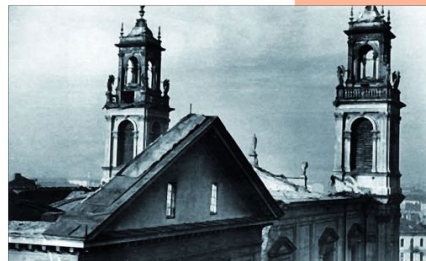
Kościół Wniebowziętych w Warszawie, wzniesiony w 1939 r.
