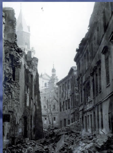
Ulica Jezuicka w Lublinie zniszczona podczas bombardowania 9 września 1939 r. Fot. AIPN
