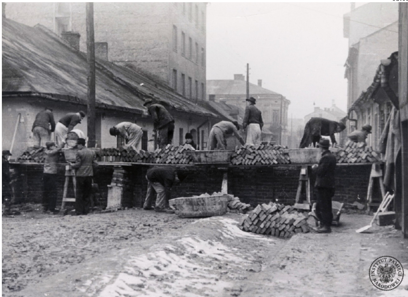
Budowa muru getta (kwiecień-maj 1941 r.) na rogu ul. Krakusa i Piwnej. Kamienica nr 22 (druga po lewej) jako jedyna wśród towarzyszących jej budynków zachowała się do dziś (fot. ze zbiorów IPN)
