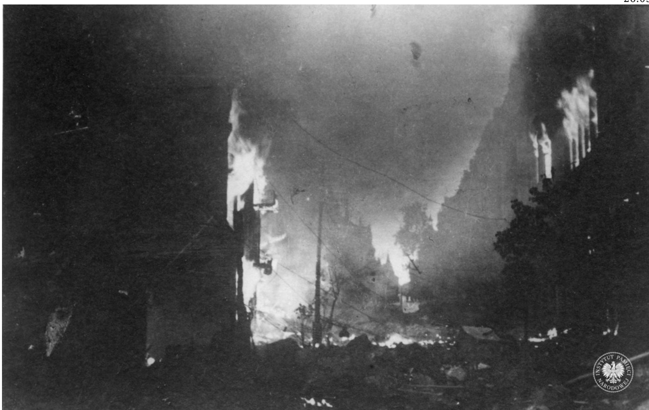
Płonąca Warszawa. Widoczny pożar budynków po obu stronach ulicy, najprawdopodobniej po niemieckim nalocie 25 września 1939 r. (fot. z zasobu AIPN)
