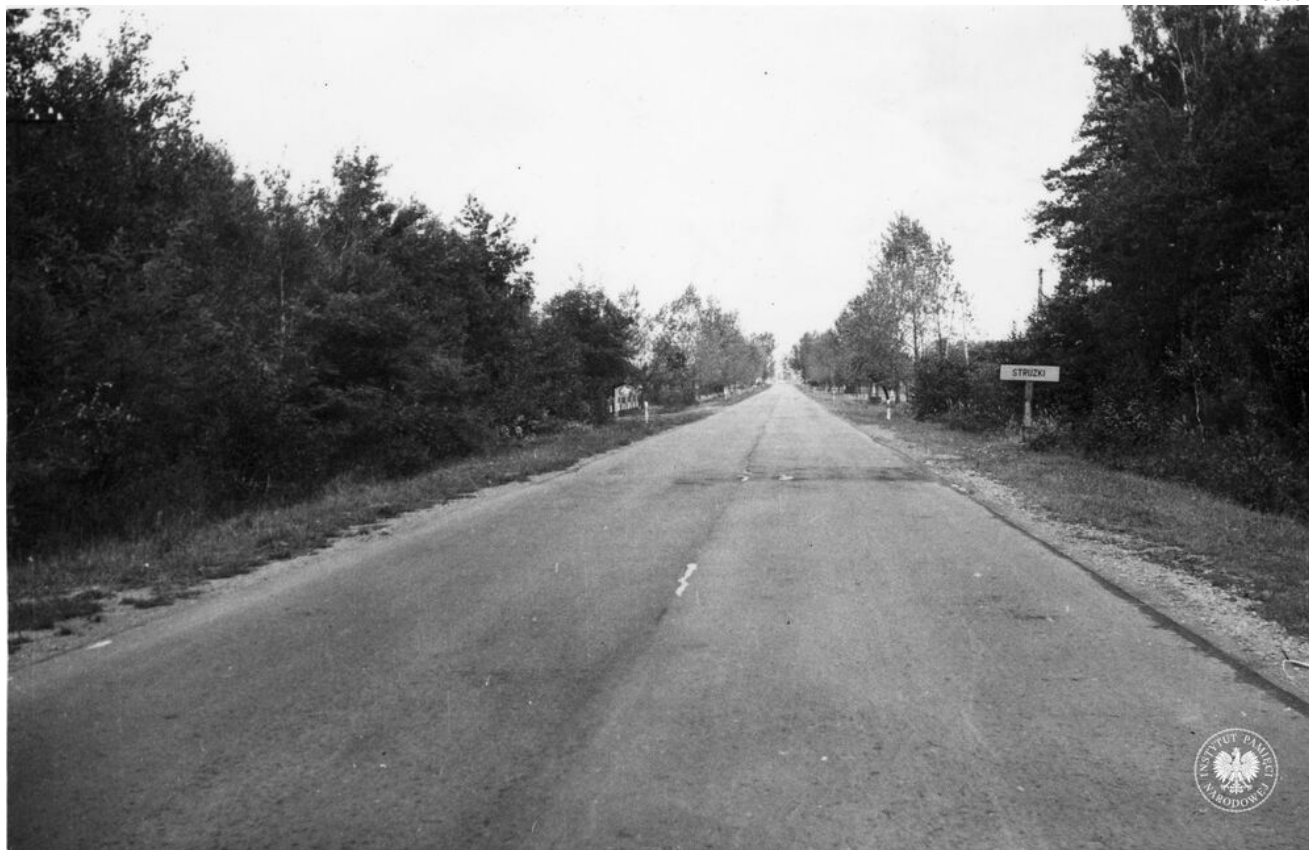
Ogólny widok drogi od strony Połańca w kierunku Strużek. Fot. AIPN
