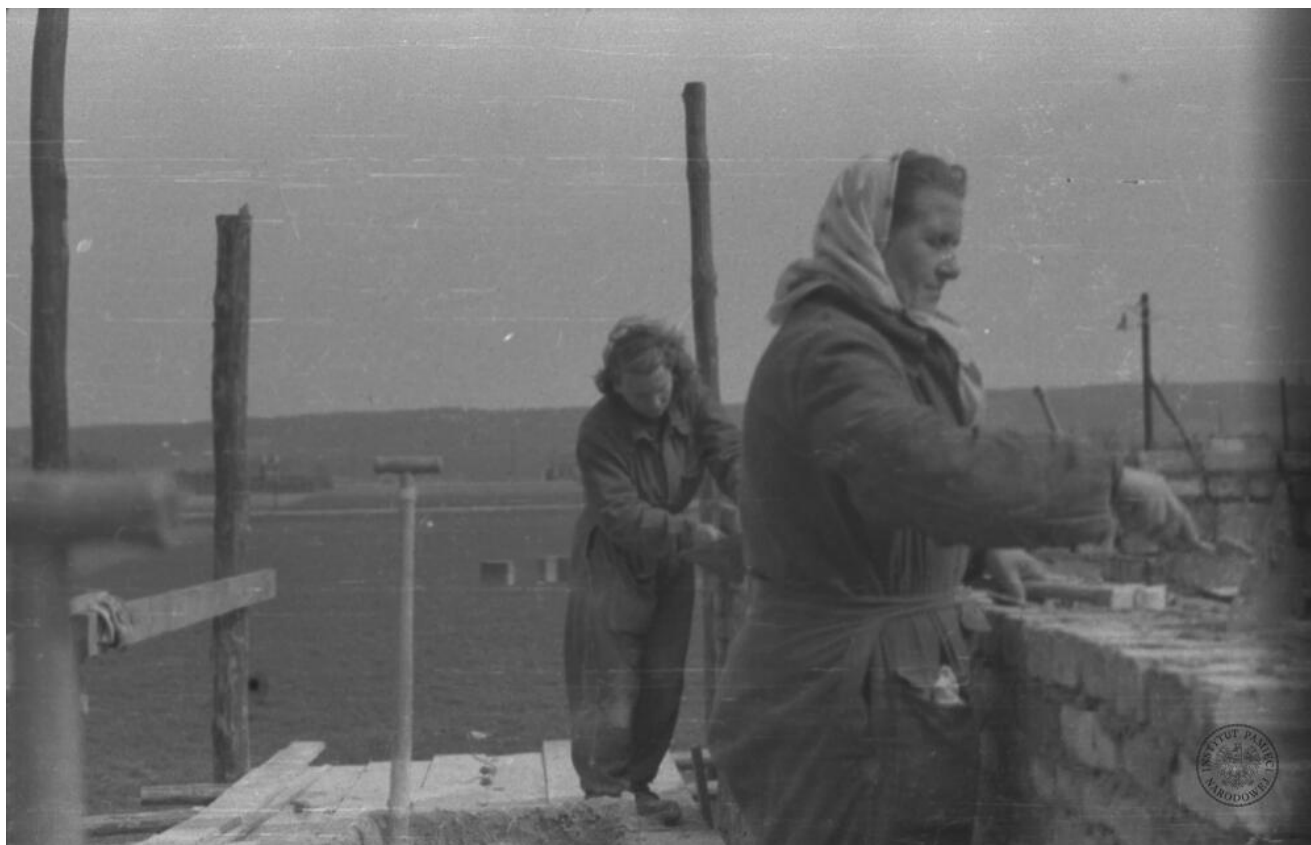
IPNBy-23-5-3-6, Prace budowlane przy jednej ze ścian budynku (widoczne: 2 NN kobiety murujące ścianę). Źródło: AIPN
