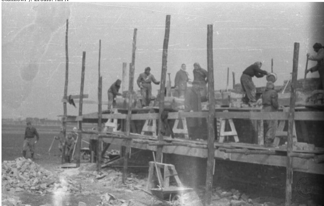
IPNBy-23-5-3-2, Prace budowlane przy jednej ze ścian budynku (widoczna kobieca brygada budowlana pracująca na drewnianej konstrukcji tymczasowej). Archiwum IPN
