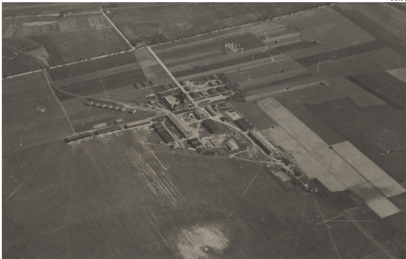
Lotnisko Ławica, widok z lotu ptaka (fot. ze zbiorów Biblioteki Narodowej)
