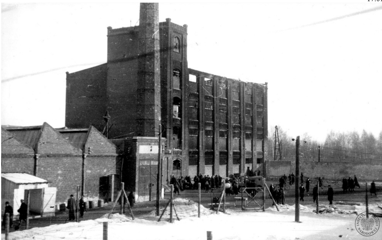
Budynki więzienne (fot. z zasobu IPN)
