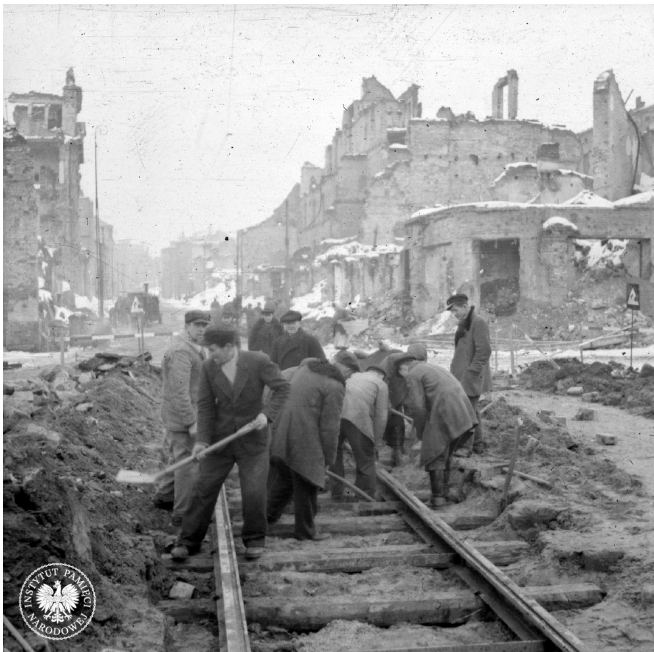
Przywracanie do użytku torów tramwajowych. Warszawa, 1946 r. Fot. Julien Bryan (z zasobu Archiwum IPN)
