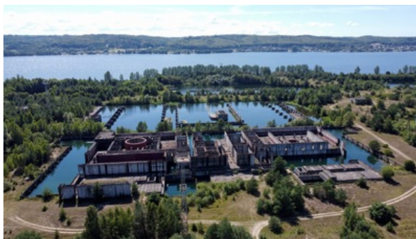
Nieukończony główny budynek Elektrowni Jądrowej w Żarnowcu, zajęcie z domeny publicznej
