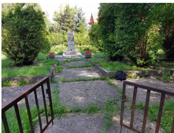
Kraków-Skotniki, lipiec 2020, remont cmentarza z II wojny światowej – cmentarz jeńców sowieckich wziętych do niewoli przez Niemców, remont przeprowadzony wspólnie z Małopolskim Urzędem Wojewódzkim. Fot. IPN
