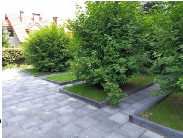
Kraków-Skotniki, lipiec 2020, remont cmentarza z II wojny światowej – cmentarz jeńców sowieckich wziętych do niewoli przez Niemców, remont przeprowadzony wspólnie z Małopolskim Urzędem Wojewódzkim. Fot. IPN
