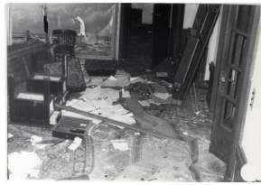
Zniszczenia wewnątrz konsulatu ZSRS (IPN Sz 009/1460)
