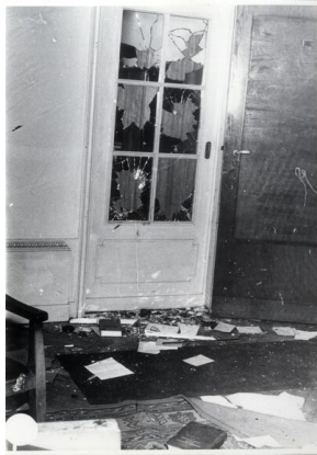
Zniszczenia wewnątrz konsulatu ZSRS (IPN Sz 009/1460)
