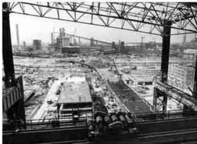
■ PODPIS Z DOKUMENTACJI ICAF. MELDUNEK Z WIELKIEJ BUDOWY – HUTA KATOWICE.
