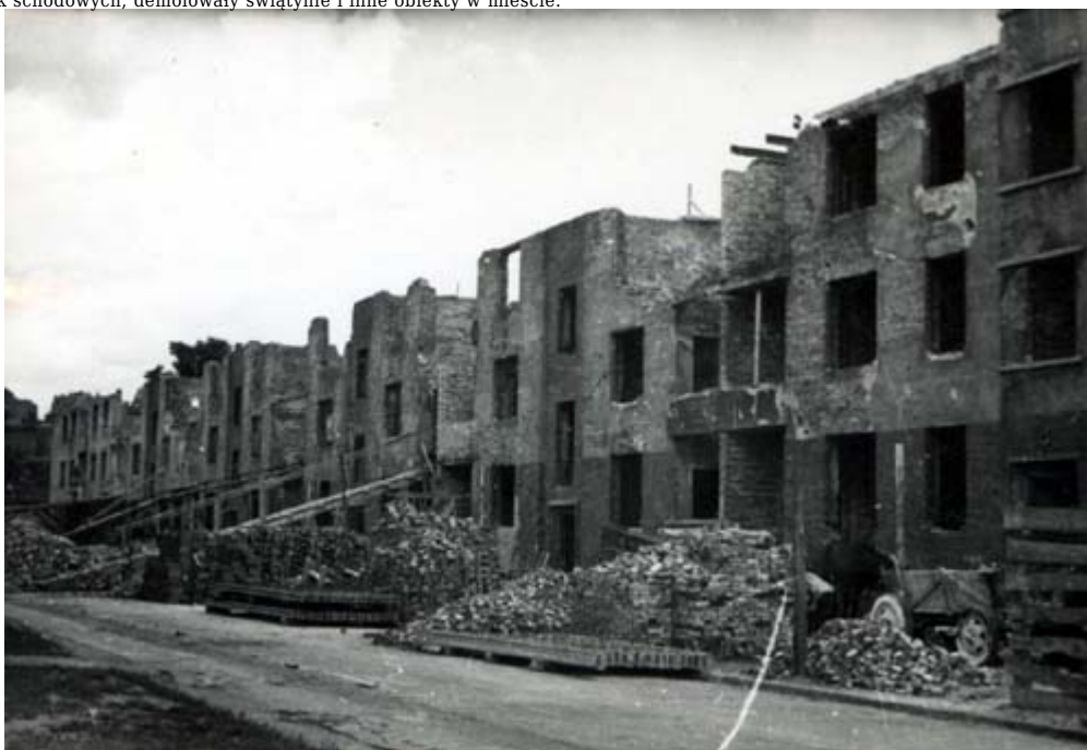
Ruiny Gdańska wiosną 1945 r. Największych zniszczeń wojska sowieckie dokonały już po pokonaniu Niemców. Grupy żołnierzy przez wiele dni wrzucały wiązki granatów do klatek schodowych, demolowały świątynie i inne obiekty w mieście.
