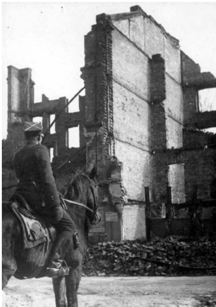
Ruiny Gdańska wiosną 1945 r. Największych zniszczeń wojska sowieckie dokonały już po pokonaniu Niemców. Grupy żołnierzy przez wiele dni wrzucały wiązki granatów do klatek schodowych, demolowały świątynie i inne obiekty w mieście.
