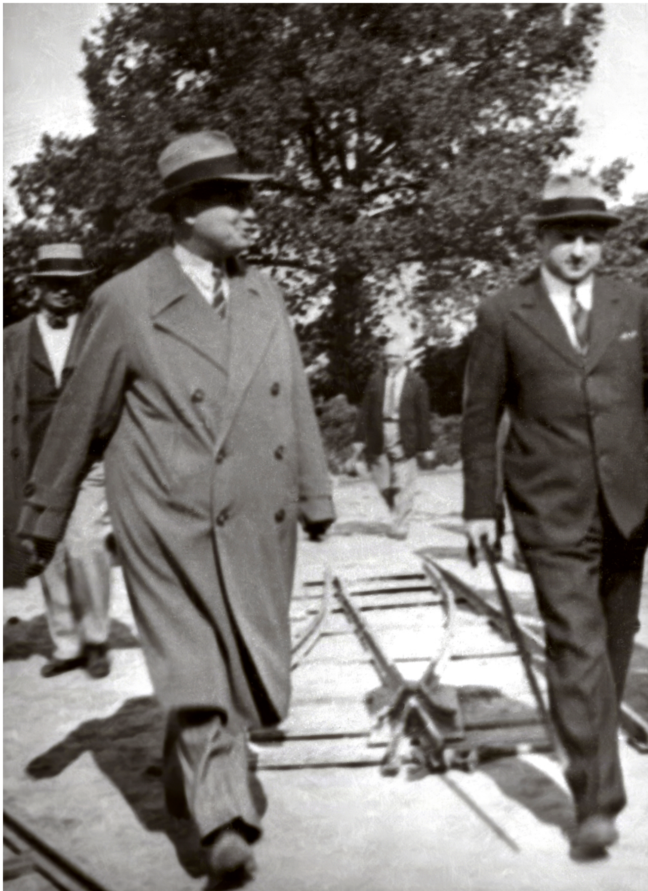
Prezydent Miasta Stołecznego Warszawy i wiceprezydent Julian S.Kulski podczas inspekcji na budowie bulwarów nad Wisłą, 1937. Fot. ze zbiorów Fundacji Kulskich
