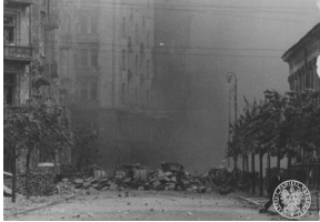
Zniszczenia zabudowy w czasie Powstania Warszawskiego (AIPN)
