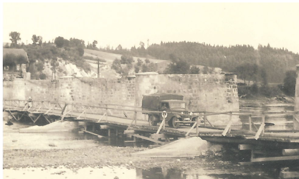
Zniszczony most drogowy w Postołowie k. Leska, druga połowa września 1939 r. (zbiory Tomasza Berezy).
