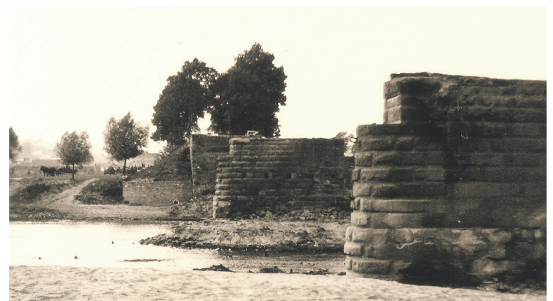
Zniszczony most drogowy na Sanie w Jarosławiu, 13 IX 1939 r. Widoczny niski stan wody w rzece (zbiory Tomasza Berezy).
