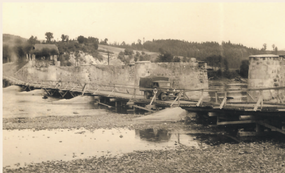
Zniszczony most drogowy w Postołowie k. Leska, druga połowa września 1939 r. Fot. Zbiory Tomasza Berezy.
