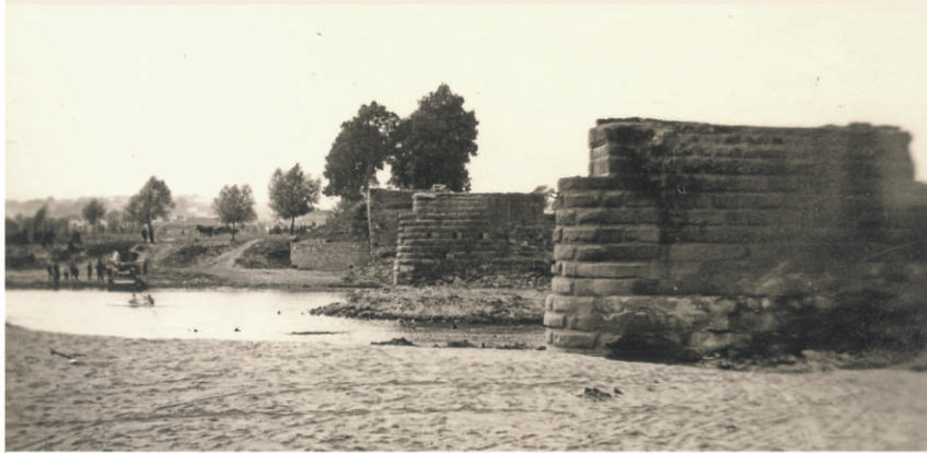
Zniszczony most drogowy na Sanie w Jarosławiu, 13 IX 1939 r. Widoczny niski stan wody w rzece. Fot. Zbiory Tomasza Berezy.
