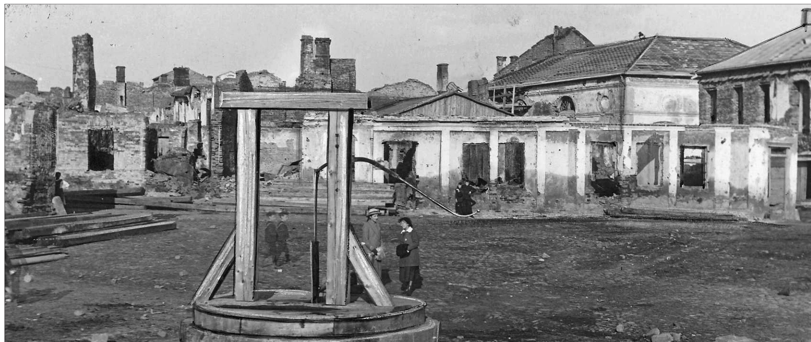
Zniszczony w wyniku działań wojennych Plac Dworzysko w Gorlicach
