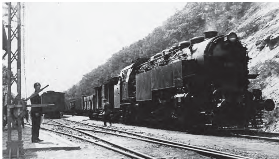
► Parowóz górski 1F2h2t wykonany przez Wytwórnię H. Cegielski w Poznaniu podczas próbnej jazdy na linii kolejowej Sofia–Warna w Bułgarii
