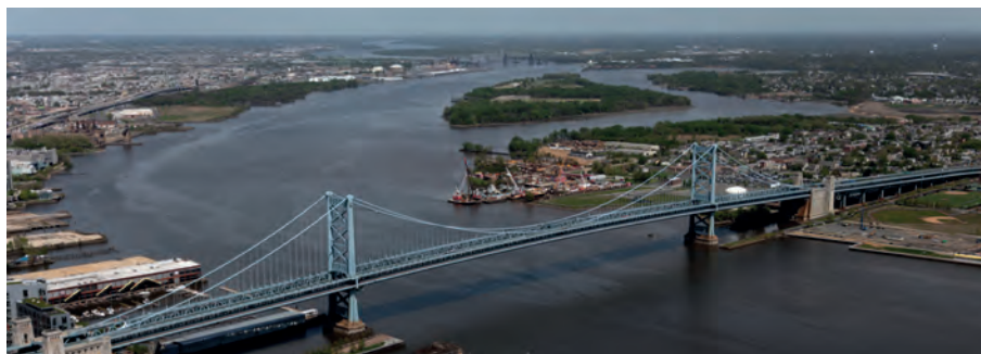
► Benjamin Franklin Bridge
