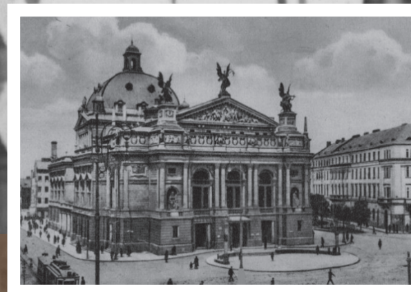
Budynek Teatru Wielkiego we Lwowie projektu Zygmunta Gorgolewskiego, wzniesiony w latach 1897–1900. Był jednym z najnowocześniejszych obiektów tego typu w Europie. Wykonawcami poszczególnych dekoracji rzeźbiarskich byli najzdolniejsi lwowscy artyści, m.in. Antoni Popiel i Tadeusz Barącz.
