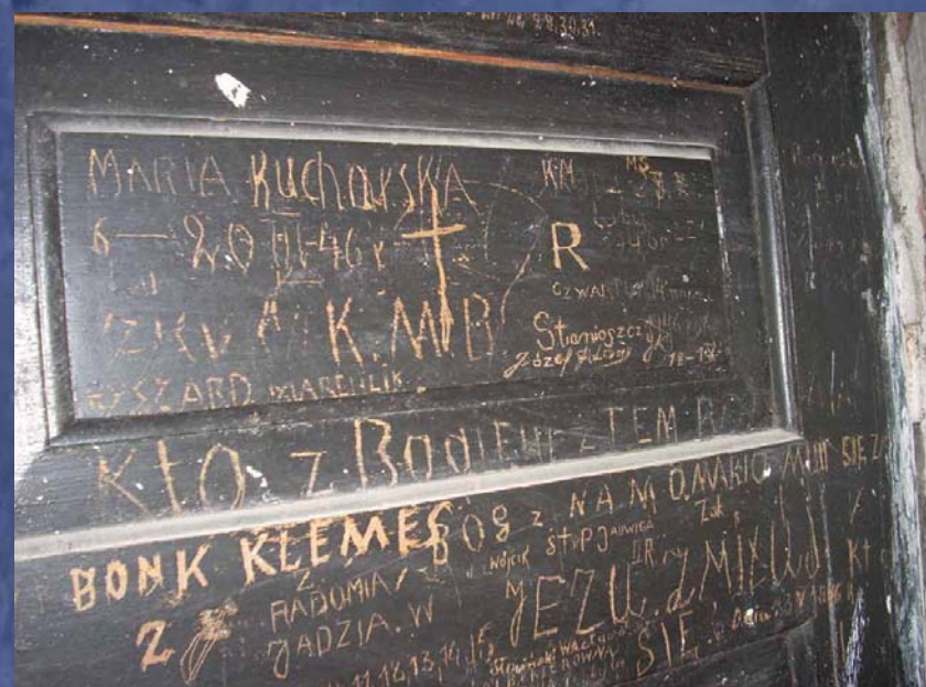
Podziemia budynku - drzwi we wnętrzu jednej z cel, na których ślady po sobie pozostawili więźniowie aresztowani zarówno w okresie okupacji, jak i w latach powojennych. Fot. Arkadiusz Kutkowski
