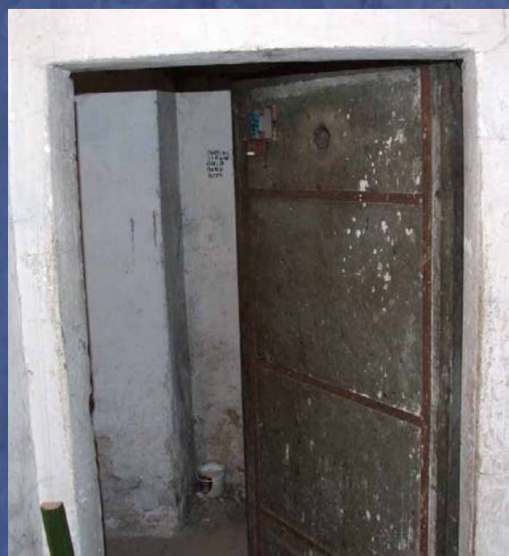
Podziemia budynku – metalowe drzwi do jednej z cel z charakterystycznym wizjerem, przez który strażnik pilnujący korytarza mógł zajrzeć do wnętrza pomieszczenia. Fot. Arkadiusz Kutkowski
