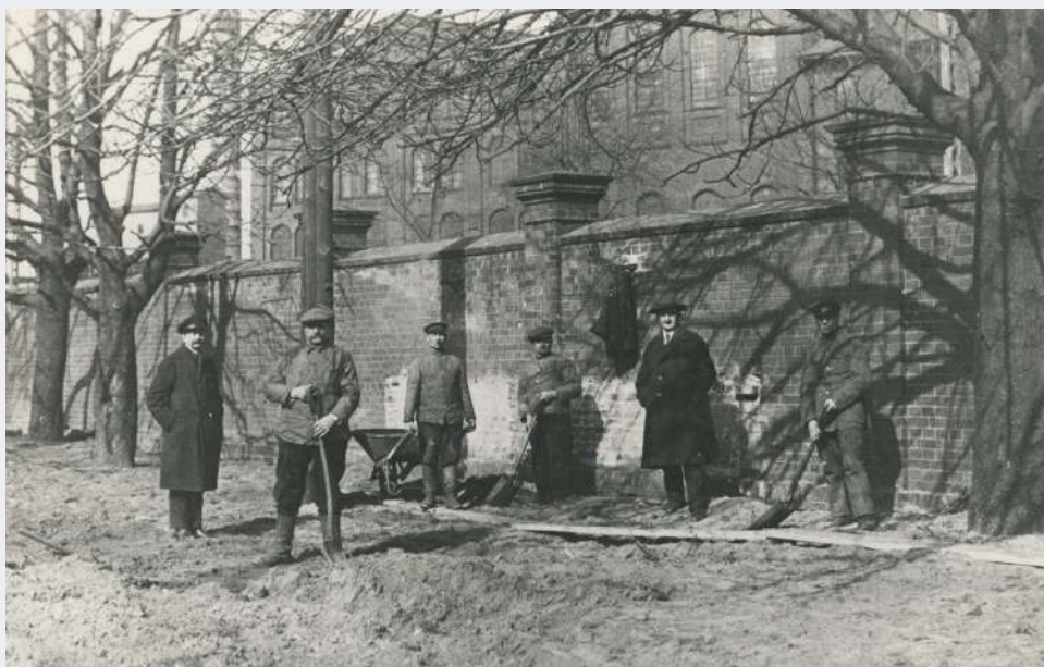
Prace adaptacyjne prowadzone na potrzeby etapu emigracyjnego. Widoczna część plotu oraz znajdująca się za nim rafineria cukru nie zachowały się do dzisiaj (MP)
