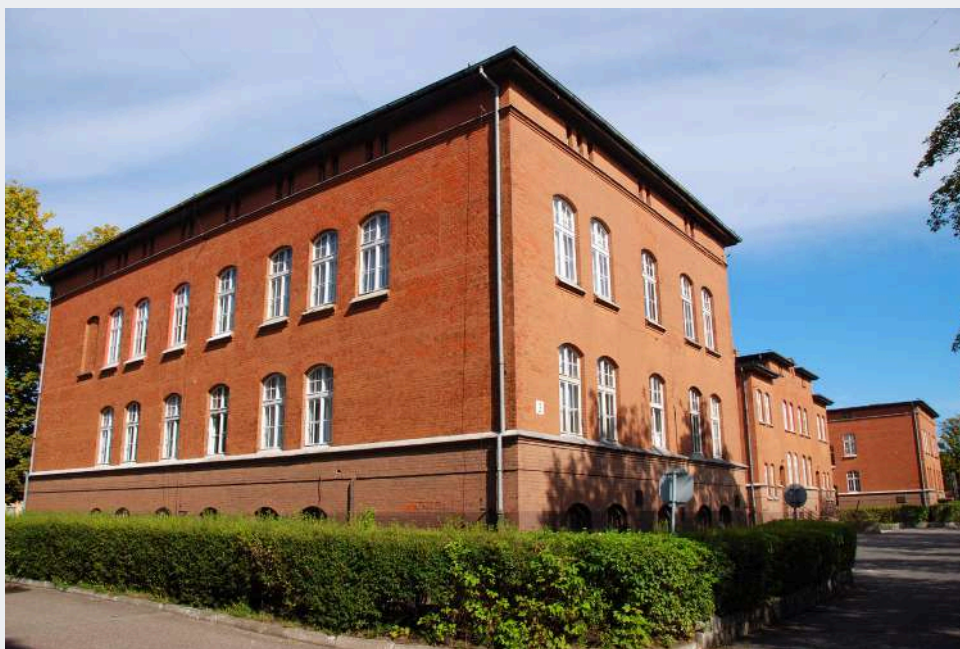
Budynek dowództwa 6 BOP (później MBOP), SSM WOP oraz Szefostwa Służby Morskiej WOP (fot. Antoni Ciejpa, MOSG)
