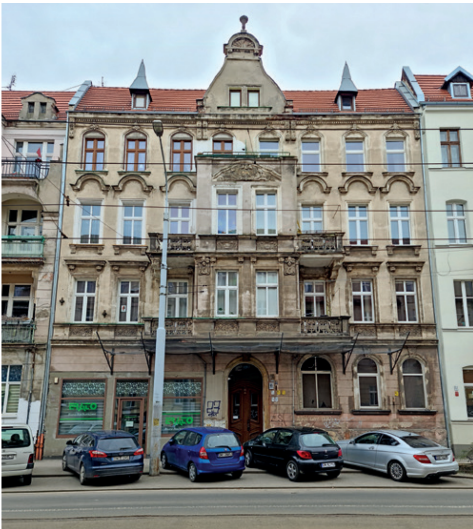
Kamienica przy ul. Sienkiewicza 93 we Wrocławiu, 2021 r. (źródło: zbiory Piotra Dyby [dalej: zbiory P.D.]
