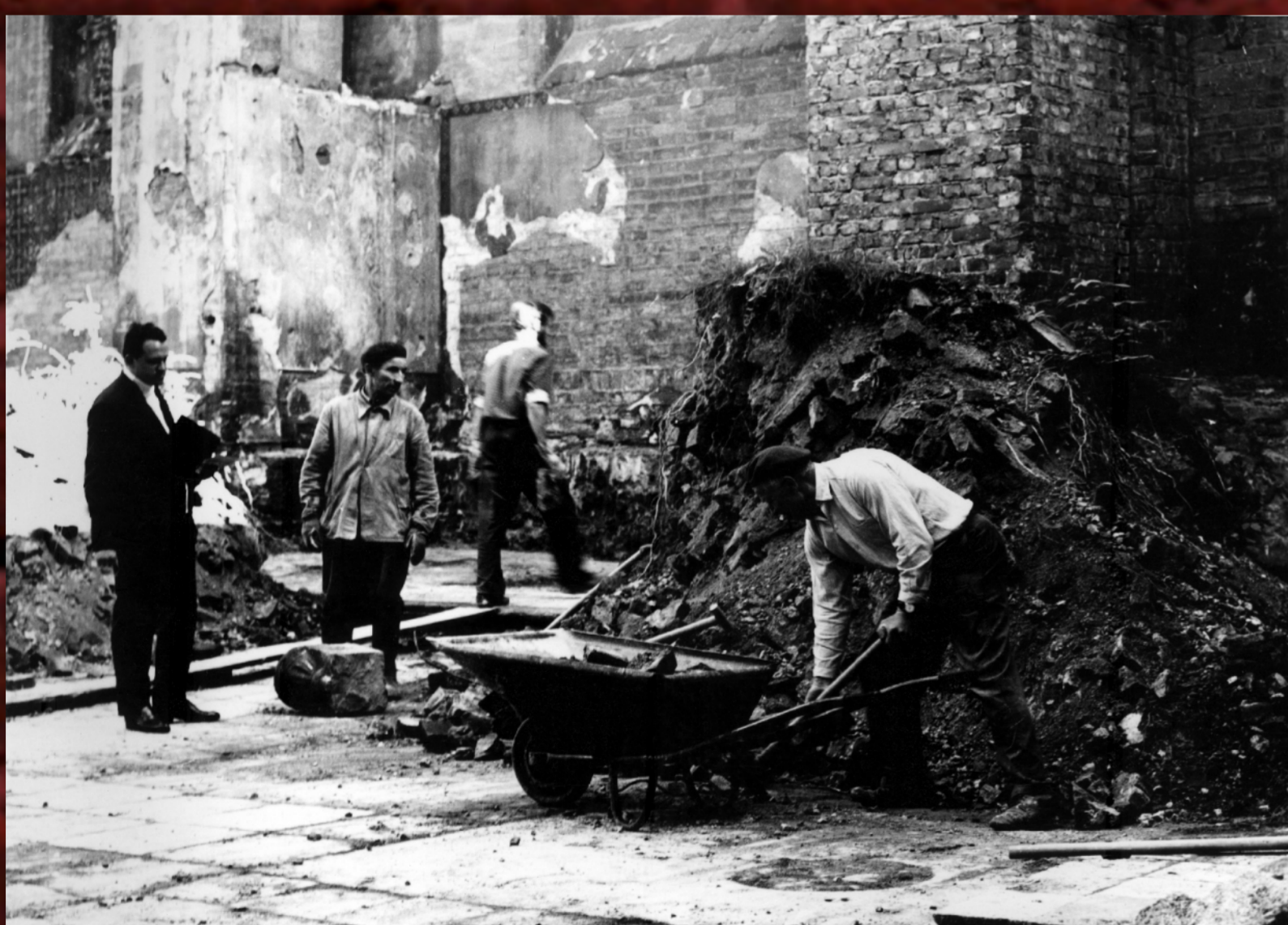
Ks. Henryk Jankowski wśród robotników podczas prac w ruinach kościoła, fot. N.N. (Archiwum Archidiecezjalne w Gdańsku)
