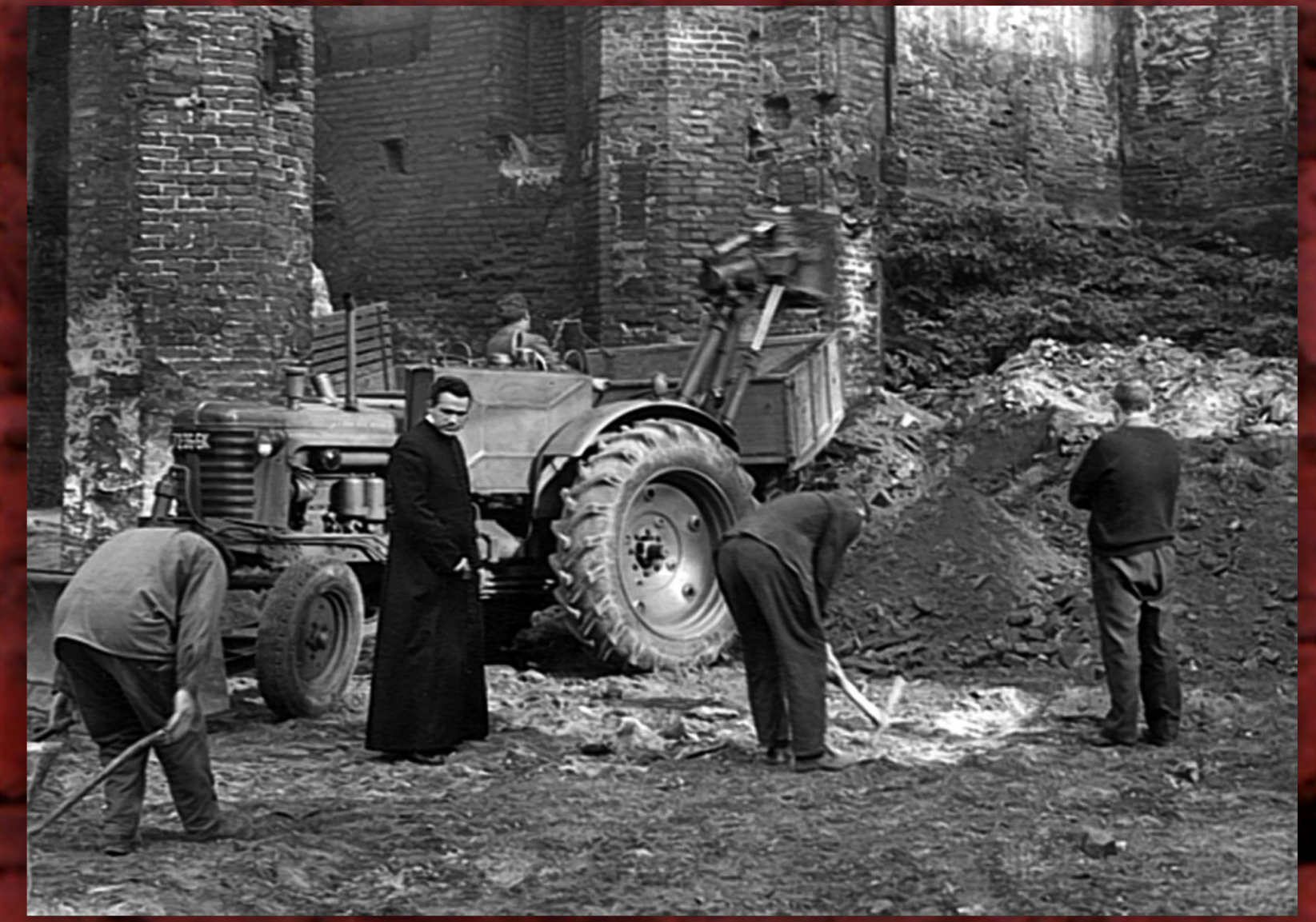
Ks. Henryk Jankowski na placu budowy w czasie odgruzowywania nawy głównej, fot. N.N. (Archiwum Parafii św. Brygidy w Gdańsku)
