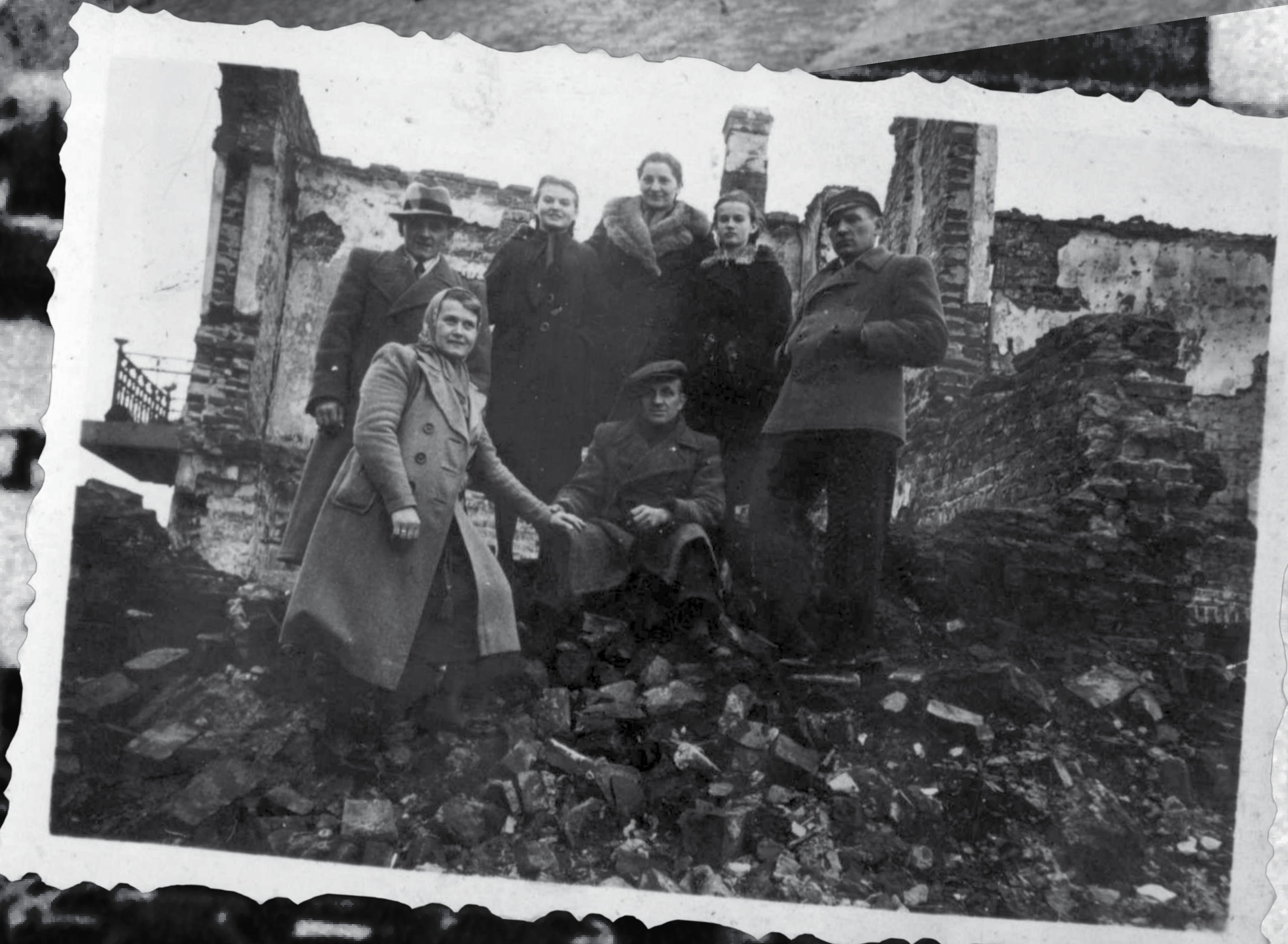
Zburzone domy w Skaryszewie. Do najbardziej zniszczonych miejscowości w okolicach Radomia należały też Zwolen i Głowaczów
