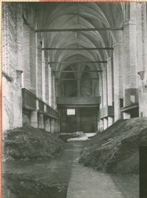
Kościół św. Jana Ewangelisty w trakcie odbudowy. „Nie ma ani jednej kłódki, wbrew pozorom próżno szukać. Sklepienie to tylko wlotowy otwór, ledwo widoczny, a w ścianach miejscami wiszący kawałki do rozdzielenia próżno rozpoznaje się też cokolwiek. Widać tylko ścianki i słupki (Kronika szczecińskiego parafialnego SAC).
