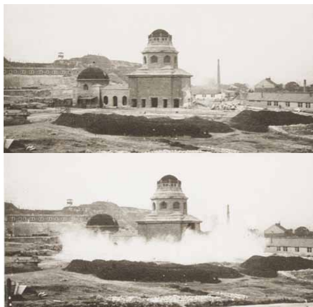
fot. 35 i 36 Wysadzenie w powietrze domu przedpogrzebo- wego
