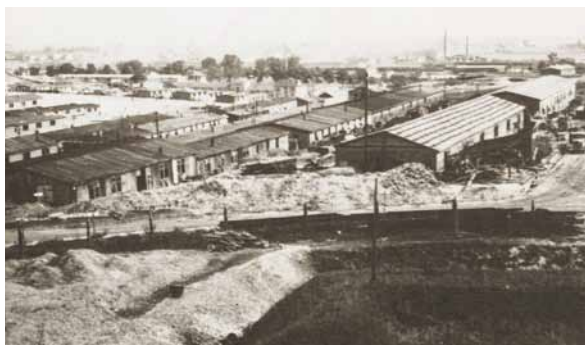
fot. 15 Panorama z wieży strażniczej. Na pierw- szym planie fragmenty dawnego szanica („Dołek”) i baraki grupy przemysłowej (dwa duże baraki sto- larni). Powyżej część placu apelowego
