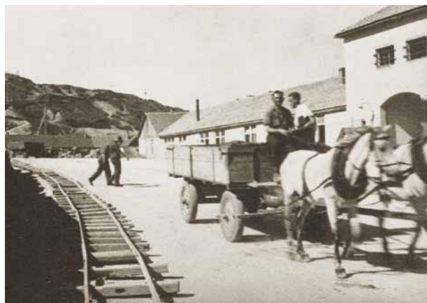
fot. 33 Powóz konny przed budynkiem koszar, tory kolejki na Hauptstrasse
