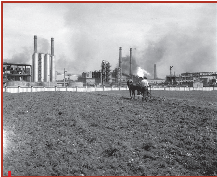
Budowa kombinatu metalurgicznego w Nowej Hucie była sztandarową inwestycją Planu Sześcioletniego
