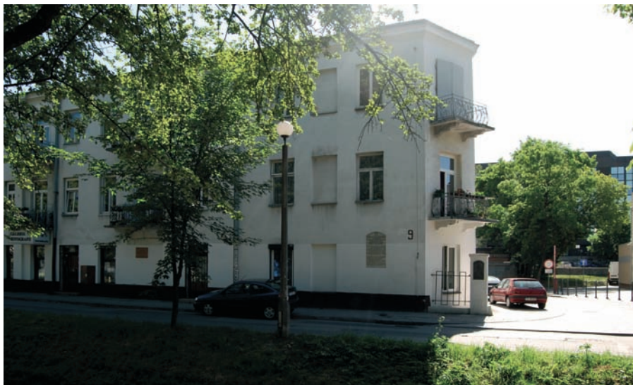
Dom przy ul. Planty 7 (obecnie 7/9). Widok spoza rzeki Silnicy. Widoczna tablica pamiątkowa
