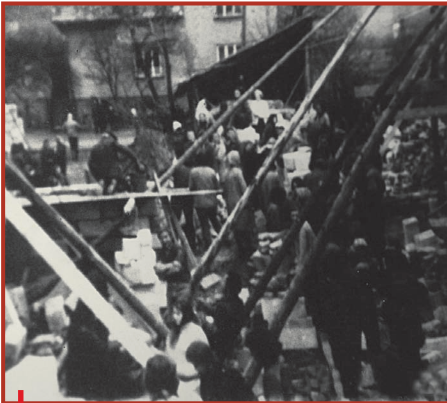
Na placu budowy 5 listopada 1972 r. – rosące błyskawicznie ściany trzeba podpierać stemplami...
