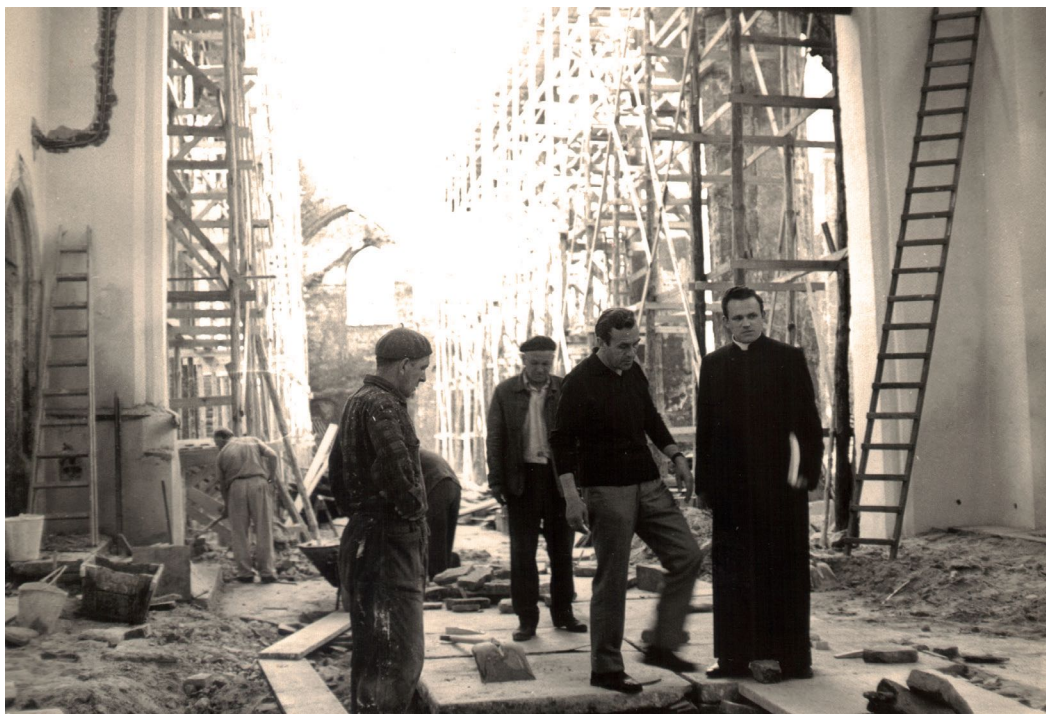
Fot. 36. Ksiądz Henryk Jankowski przy odbudowie nawy głównej kościoła św. Brygidy w Gdańsku, marzec 1971 r. (AAG)
