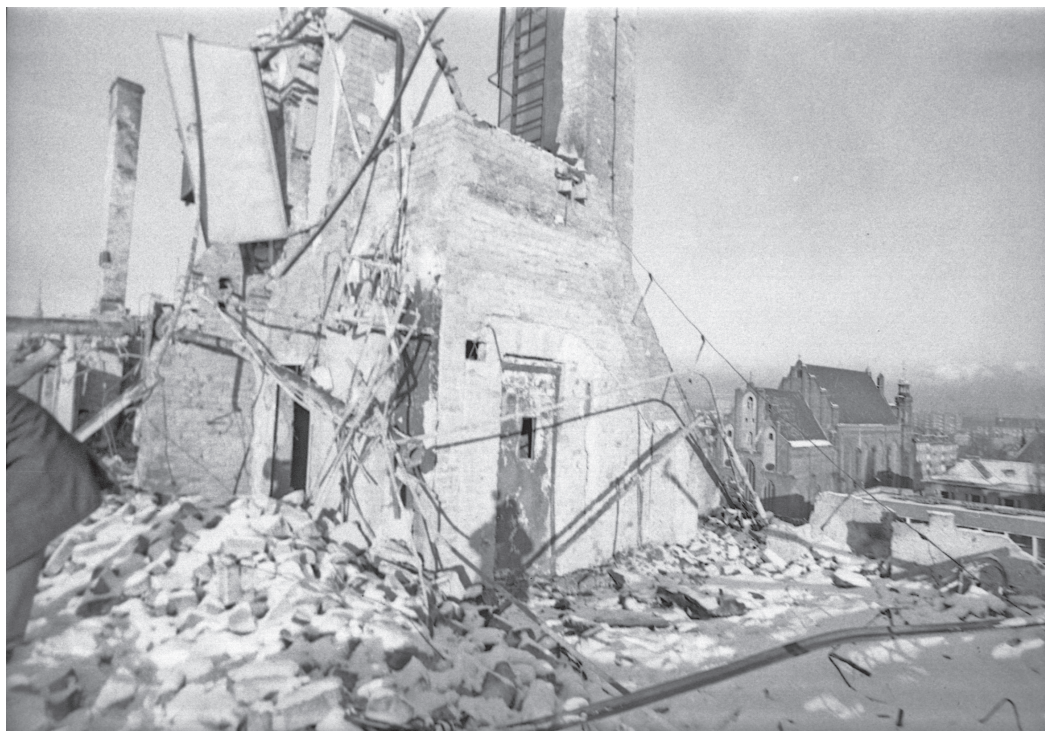
Fot. 8. Górna kondygnacja zniszczonego budynku KW PZPR. W tle kościół św. Józefa (AIPN Gd)
