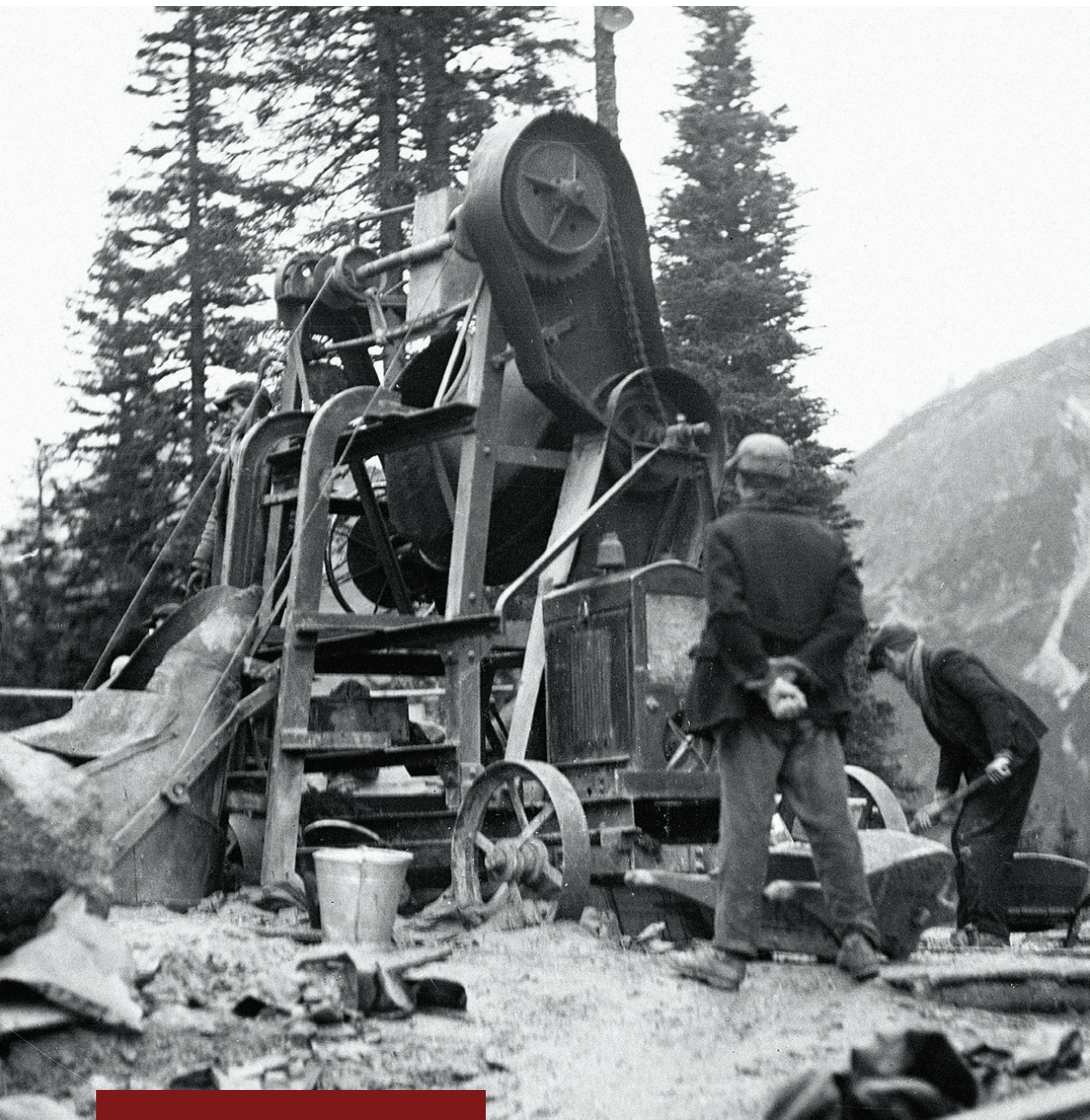
■ WZNOSENIE BUDYNKU STACJI NA KASPROWYM WIERCHU, 1935 R. FOT. NAC
