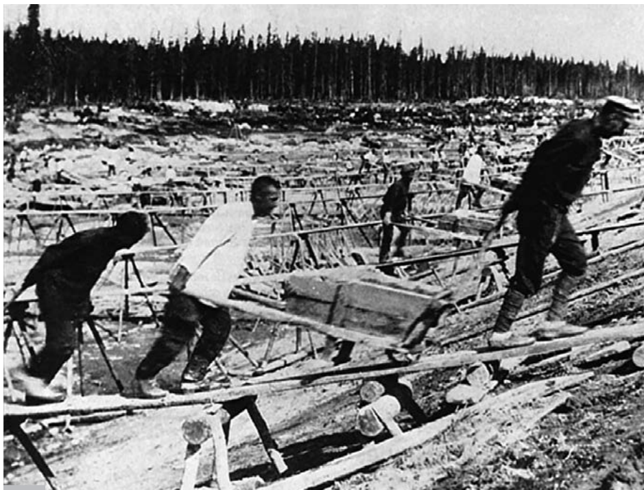
Łagiernicy przy budowie Kanału Białomorsko-Bałtyckiego, między 1930 a 1933 r. Fot. Wikimedia Commons
