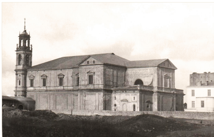
Plebania kościoła Wszystkich Świętych w Warszawie (budynek w głębi), stan odbudowy na dzień 21 III 1948 r. (fot. Czesław Czerwiński)
