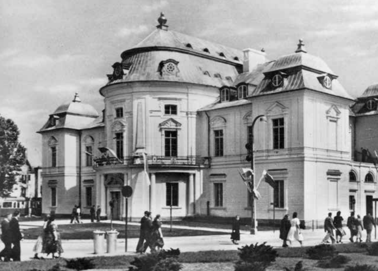
Pałac Radziwiłłów przy ul. Bielańskiej w czasie okupacji. Fot. ze zbiorów Krystyny Radziwiłł-Milewskiej
