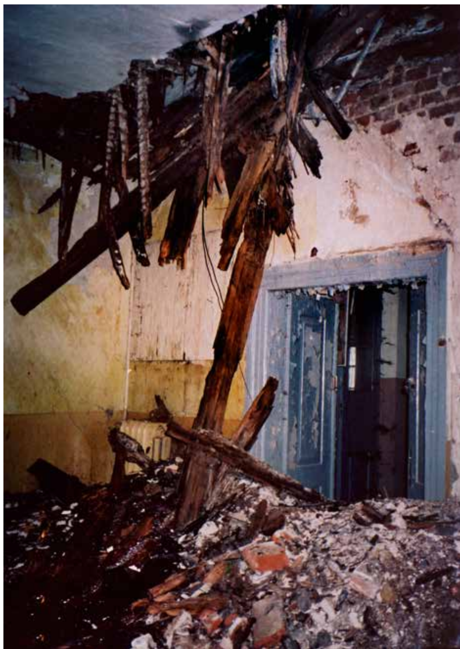
Wnętrze dworu w Kopydłowie (dziś: woj. wielkopolskie, pow. koniński), stan obecny. Fot. Tomasz Łuczak
