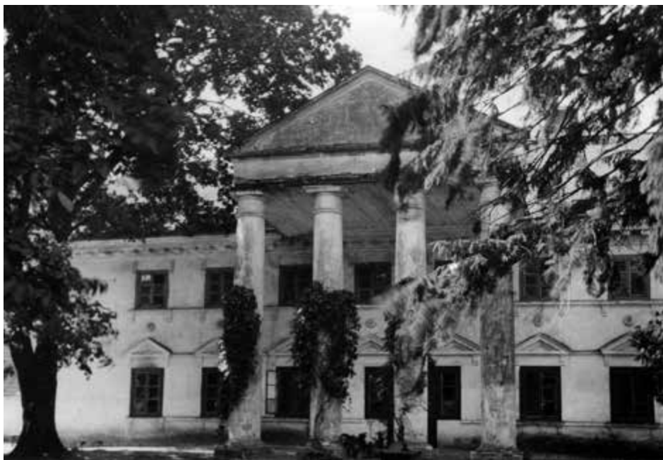
Dwór Marii Rodziewiczówny w Hruszowej od frontu (dziś: Białoruś, obw. brzeski), 1936 r. Fot. Narodowe Archiwum Cyfrowe
