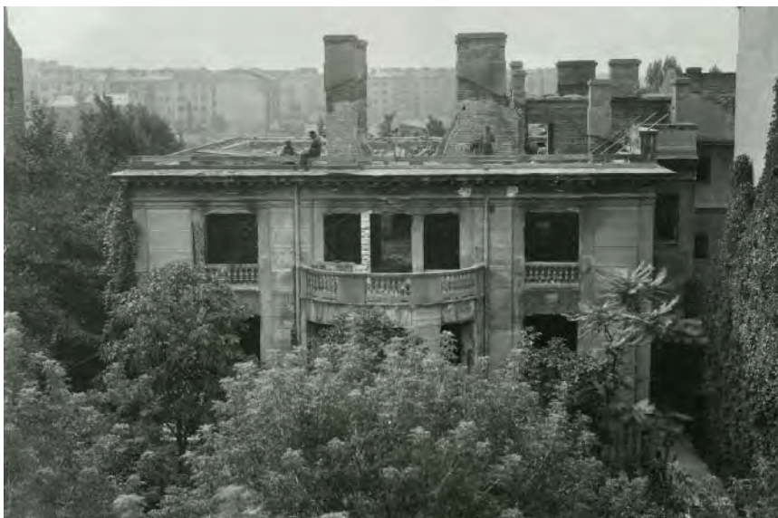
Odbudowa willi (1946 r.). Widok od strony ogrodu
