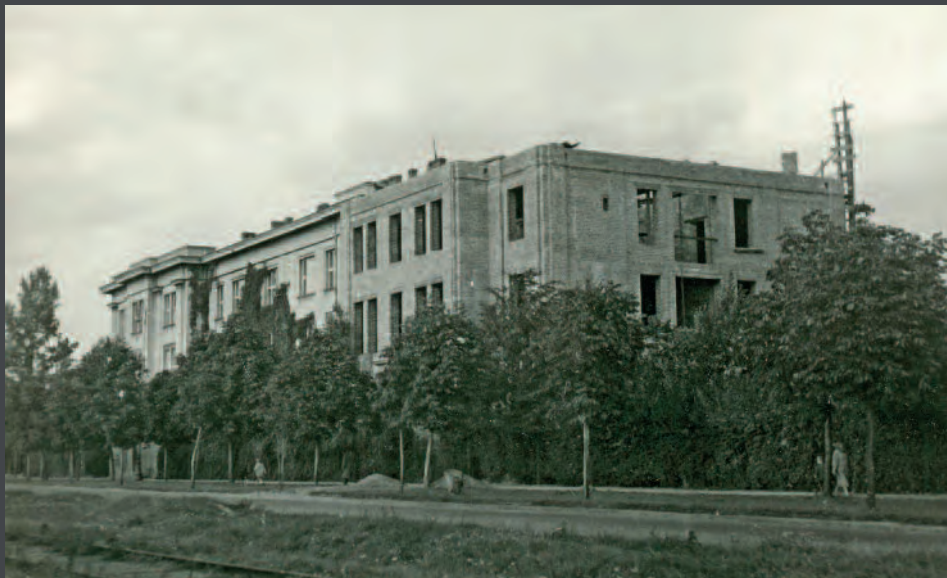
Rozbudowa Domu Pisarzy. Widok od ul. św. Andrzeja Boboli
