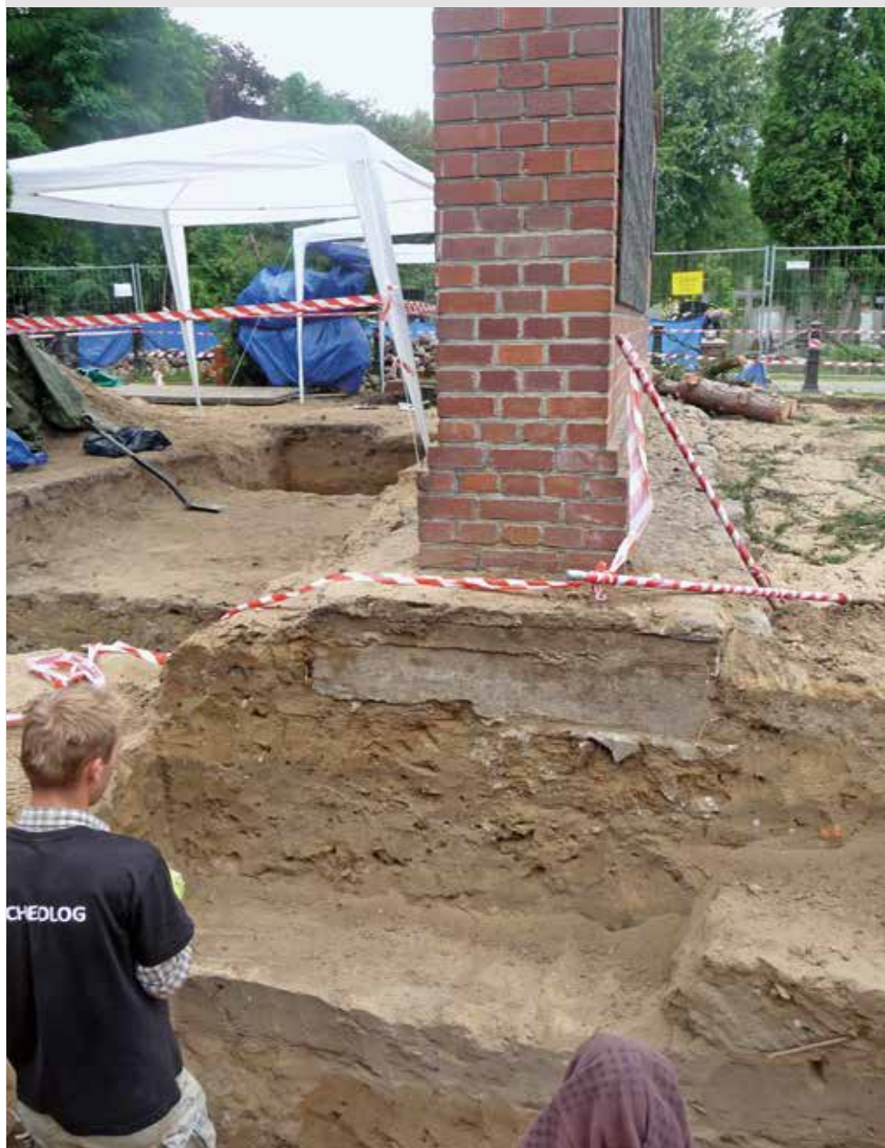
Jedna z tajemnic Łączki. Płytki fundament pod pomnikiem.
