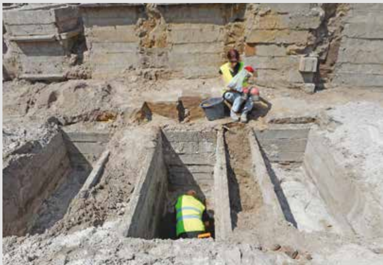
Rozbiórka pomników grobowych z lat osiemdziesiątych przeprowadzona w 2017 r.
