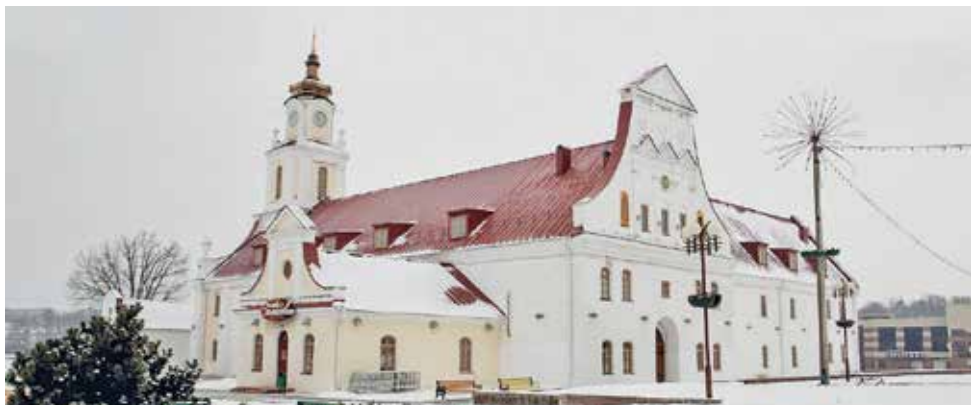
Ryc. 1. Współczesny wygląd dawnego kolegium jezuickiego (fot. Radio Svaboda).
