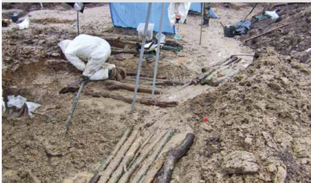
Ryc. 32. Stary Grodków, gm. Skoroszyce, pow. nyski, woj. opolskie. Rów 8 w trakcie eksploracji. Widok od północnego zachodu, 31 III 2016 r. (fot. T. Borkowski).
