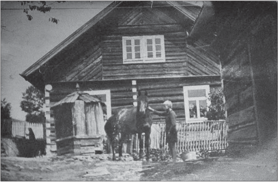
■ Dom rodziny Gołdynów na osiedlu Twarogi w Ochotnicy Dolnej. Zbiory Marka Kurzei
