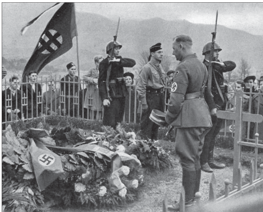
Członkowie Hlinkovej Gardy pełniący straż przy grobie ks. Andreja Hlinki. Zbiory IPN ■
