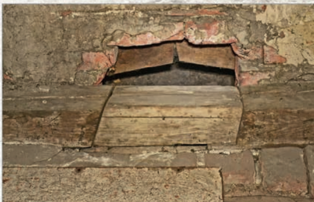
37. Skrytka widoczna po zdjęciu arkusza blachy zasłaniającego przecięcie belki stropowej i samą wnękę skrytki, 2016 r.
