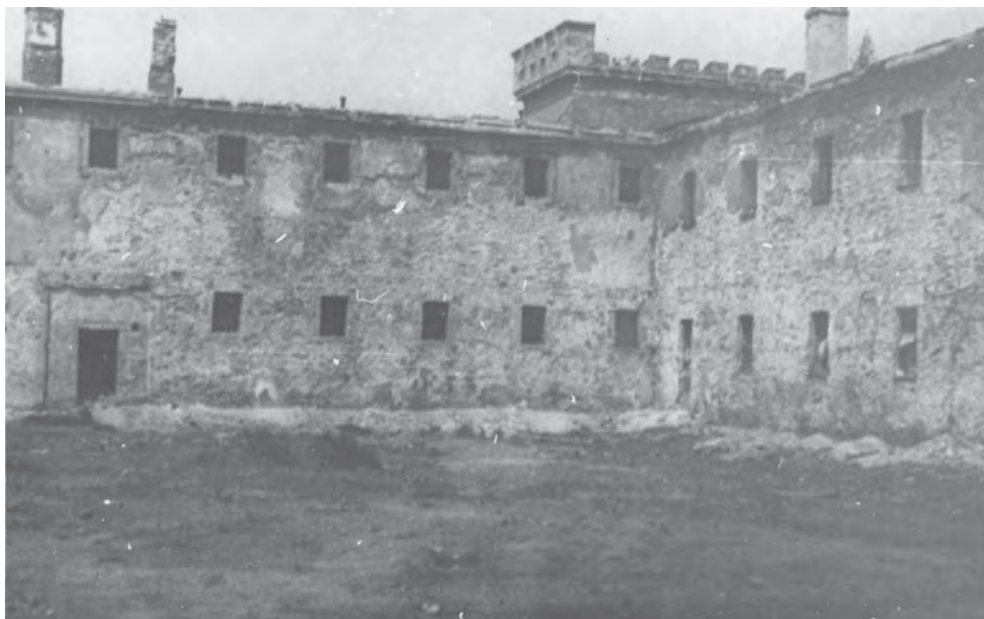
16. Południowo-zachodnie podwórze Gęsiówki od ul. Gęsiej. Rok 1945.
