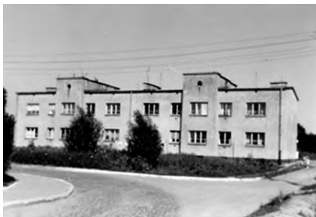
Budynek, w którym prawdopodobnie mieszkali członkowie SS, m.in. komendant obozu Reinhold Feix, zob. fotografia górna na s. 43
