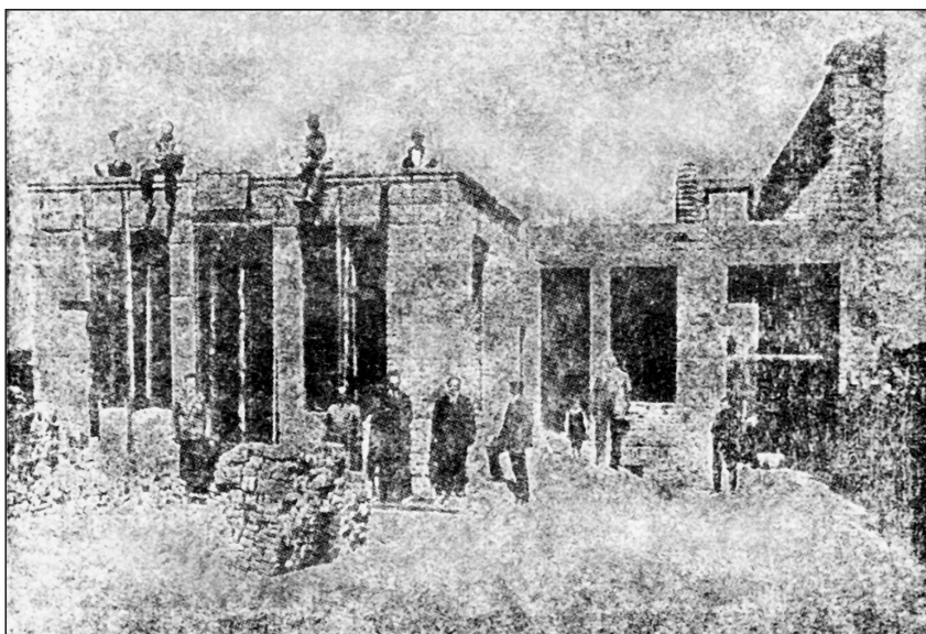
Budowa piekarni mechanicznej w Będzinie finansowana ze środków spółdzielni żydowskiej.
